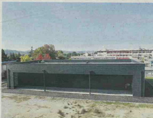
La nouvelle halle technologique de CANOE à Lacq, au sein de laquelle doivent être mis au point les matériaux verts du futur. © CHEMPARC
